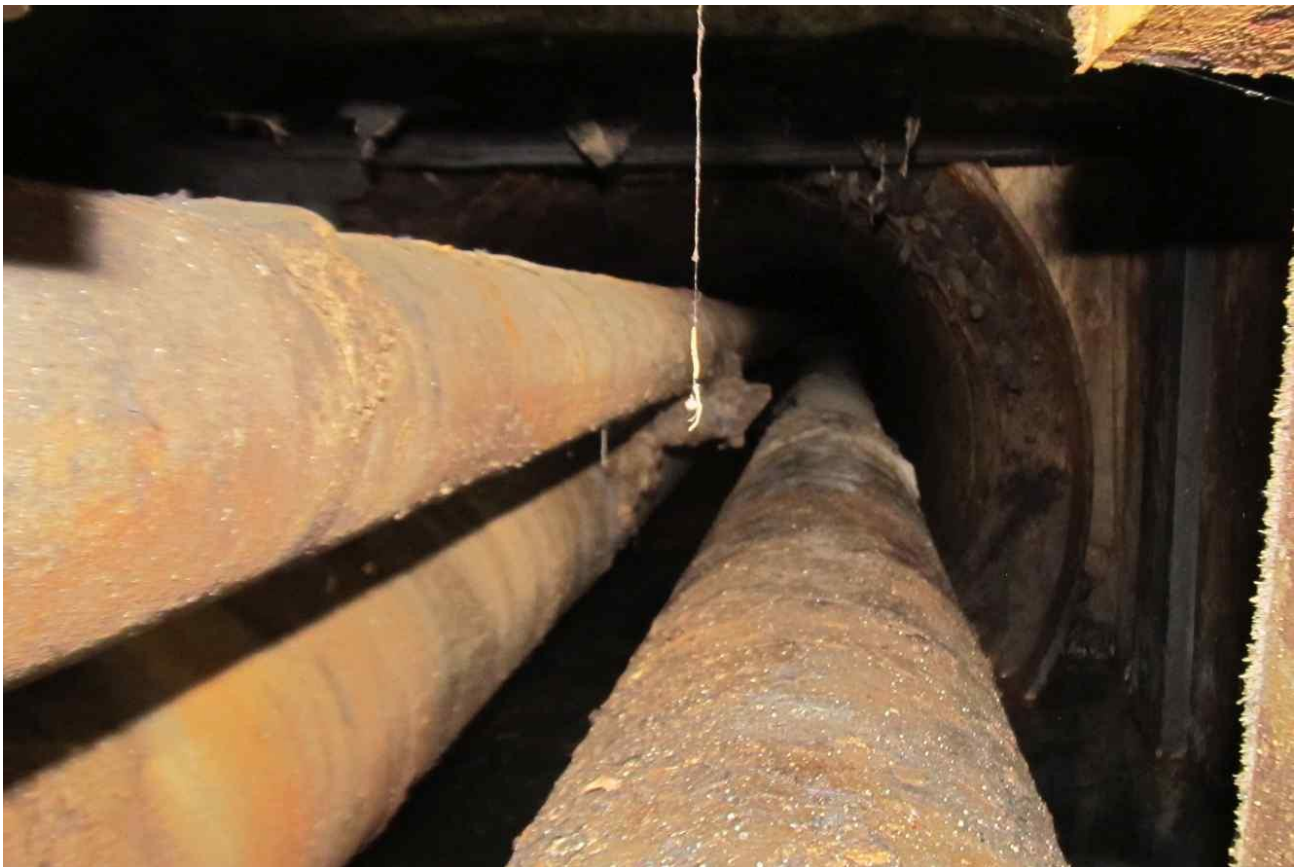
Vstup stávajícího potrubí z kanálu do chráničky DN800 směrem k objektu 220
