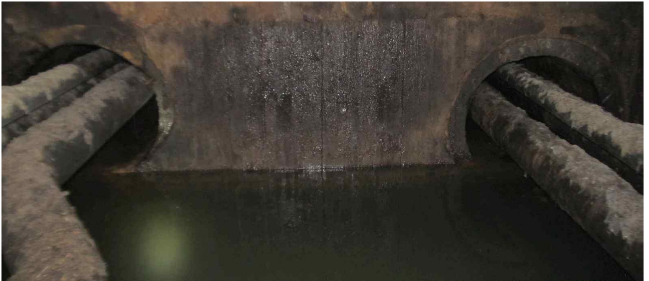
Původní potrubí v chráničkách DN800
